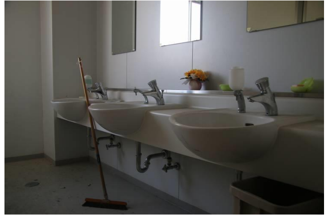
改修されたばかりの手洗い場
