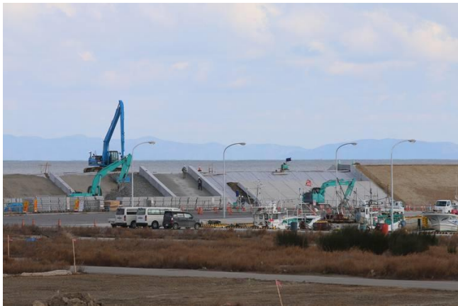
沿岸部で建設が進む防潮堤 [「日和山」より]
