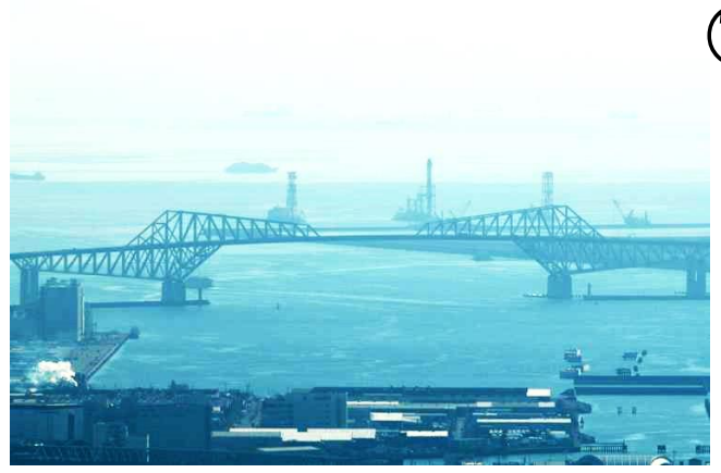
「東京ゲートブリッジ」
